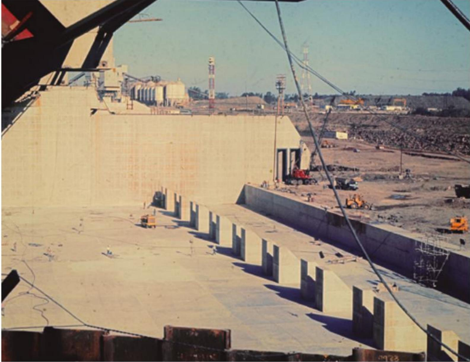
Dados disipadores en vertedero y muro que contiene la escala de peces.
