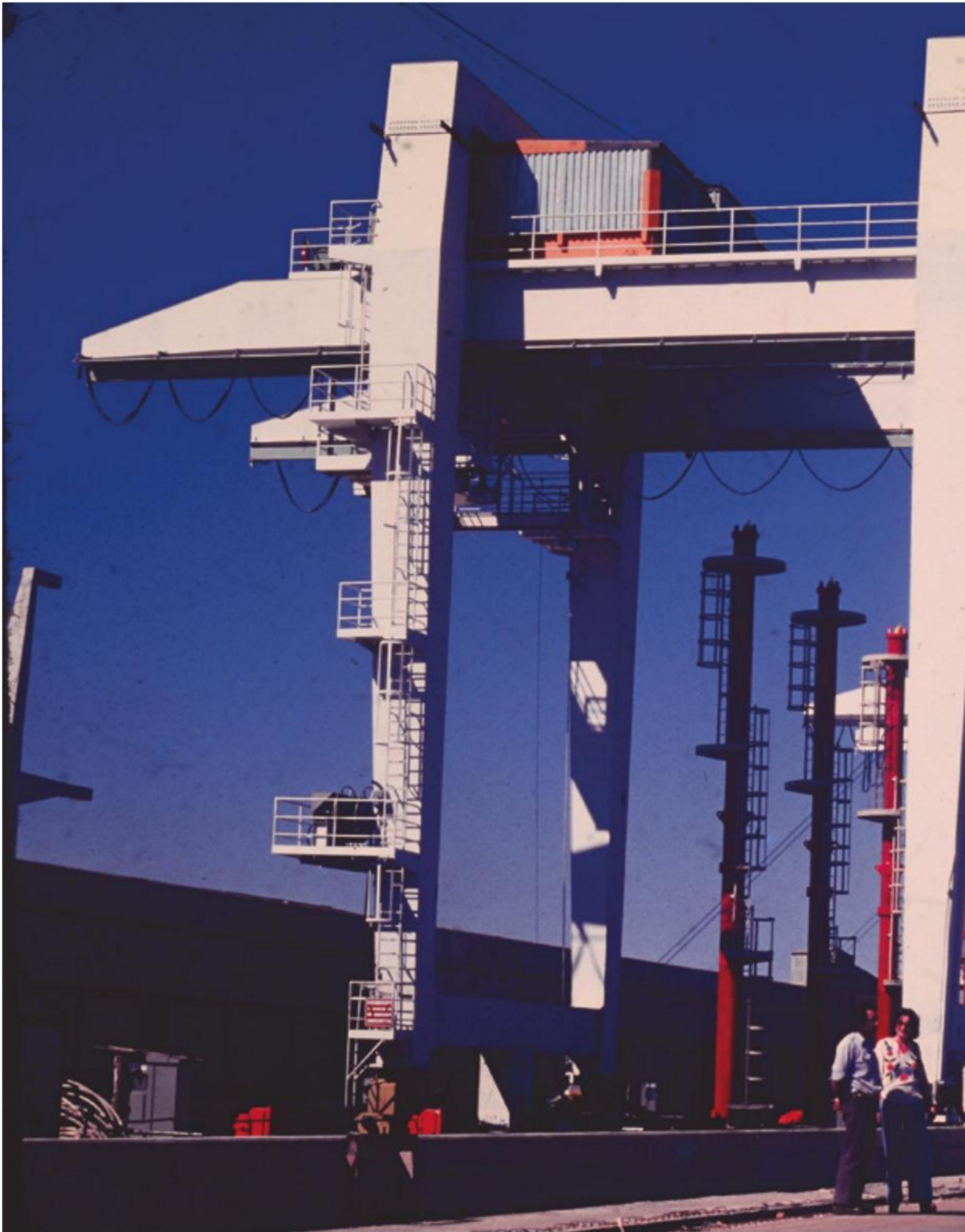
Las grúas pórtico accionan las compuertas planas de las centrales aguas arriba.
