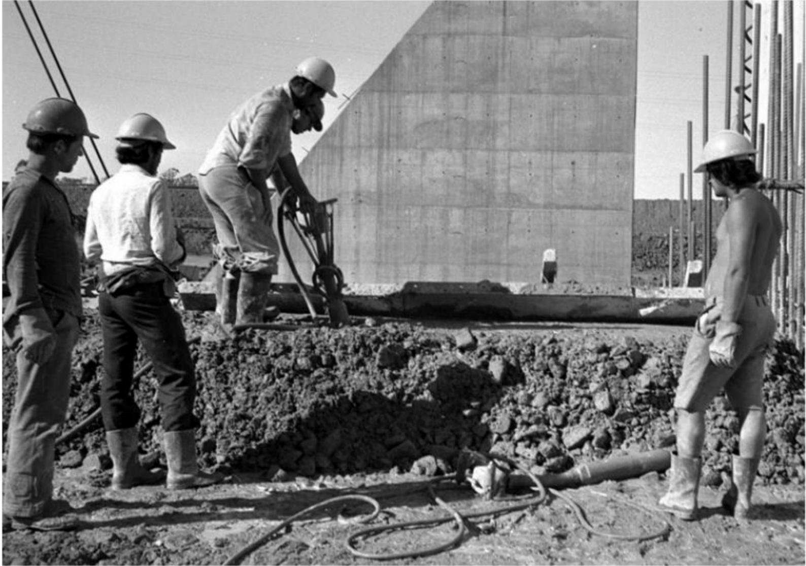
Uso de vibradores en la colada de hormigón.
