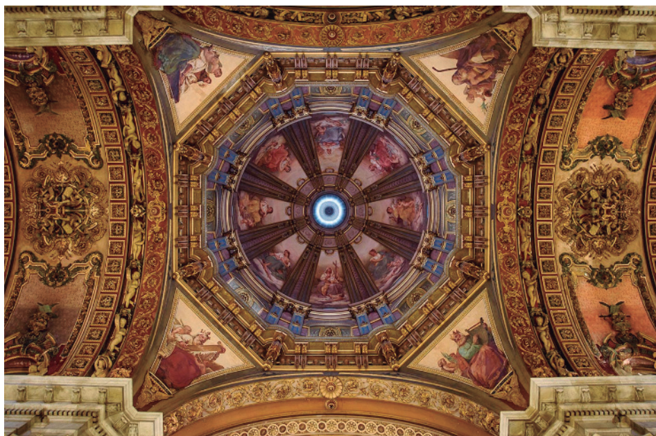
Encontro dos tetos das capelas fundas com a Nave central [2]
