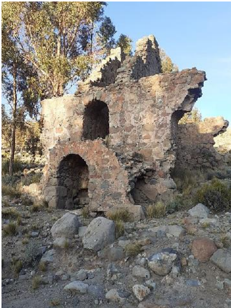
Cárcamo actual en Potosí. Son visibles (detrás) las arcadas que sostenían la rueda moledora
