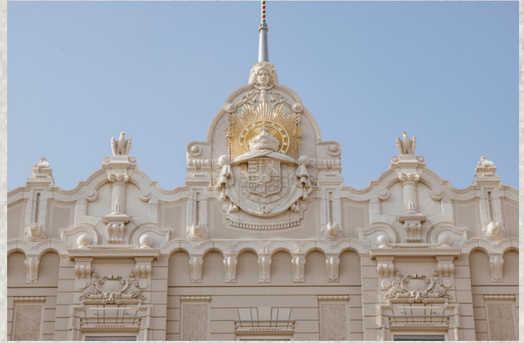
Las armas del reino de Hungría, presentes en el frente del edificio reconstruido
