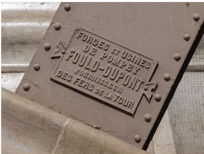
Otro aspecto a tener en cuenta es que por esa época aún no existían métodos de unión por soldadura, las uniones eran abulonadas o con remaches en caliente (roblo-nes). Esto último consistía en presentar las dos piezas haciendo coincidir los orificios ya dispuestos para eso, colocar el roblón o remache previo a calentarlo al "rojo vivo", una vez colocado se martilla o remacha la punta con una herramienta especial que le da la forma cóncava. Al remacharlo de esa
