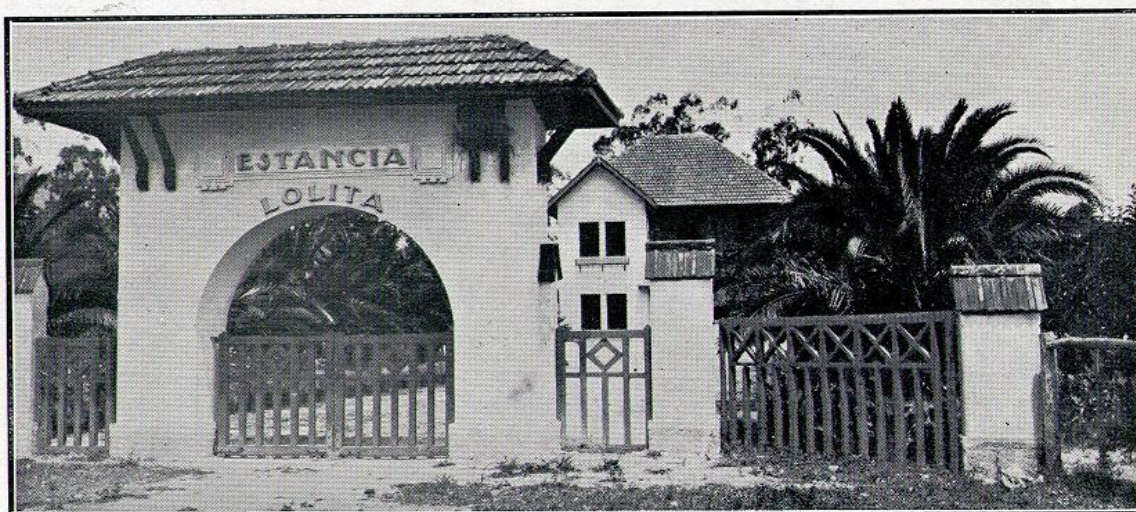
Vista de la entrada orientada al Norte
