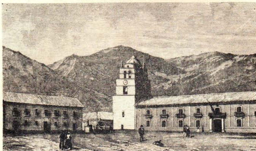
Plaza Mayor de Oruro, con vista de la Casa de Gobierno donde se pensaba instalar la Casa de Moneda.
